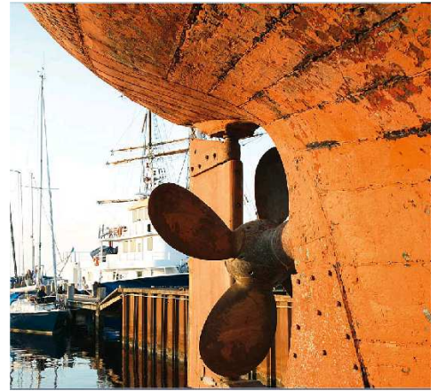
Fig.1 coque d'un bateau corrodé
