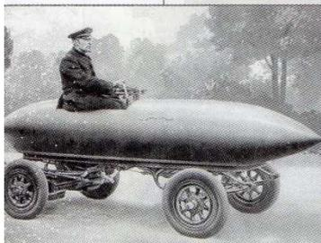
La « Jamais Contente », une voiture électrique, fut la première à franchir la barre des 100 km · h<sup>-1</sup>. Ce record, ainsi que le développement des tramways et des trains, fit croire à l'avènement de l'électricité dans le domaine du transport.
